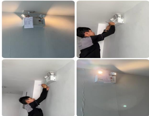
ภาคผนวกที่ 3.12 การตรวจสอบระบบไฟสำรอง
