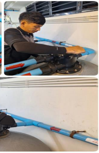
ภาคผนวกที่ 3.24 การทำความสะอาดระบบกรองสระน้ำ
