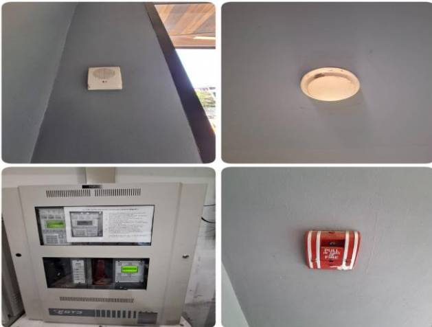
ภาคผนวกที่ 3.11 การตรวจสอบระบบเตือนอัคคีภัย
