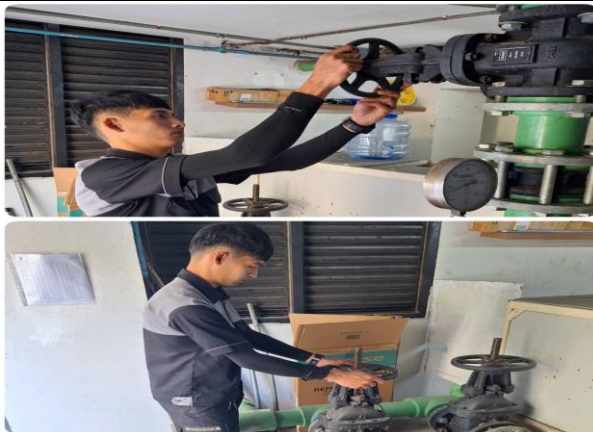
ภาคผนวกที่ 3.21 ตรวจสอบวาล์วเปิด-ปิด ถังเก็บน้ำ
