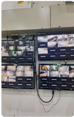
ภาคผนวกที่ 3.19 ระบบ CCTV ภายในโครงการ
