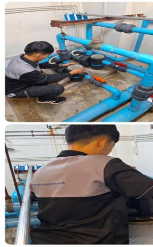
ภาคผนวกที่ 3.24 การทำความสะอาดระบบกรองสระน้ำ
